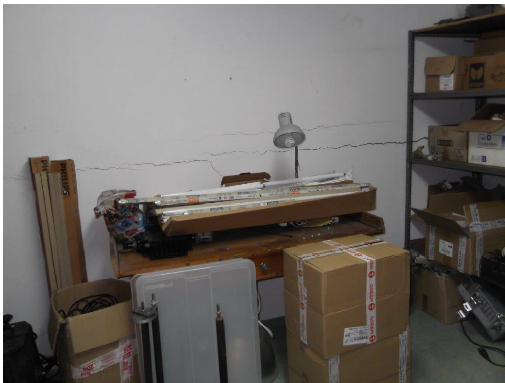
Fot. 5 Pęknięta ścianka działowa na skutek osiadania posadzki - piwnica
