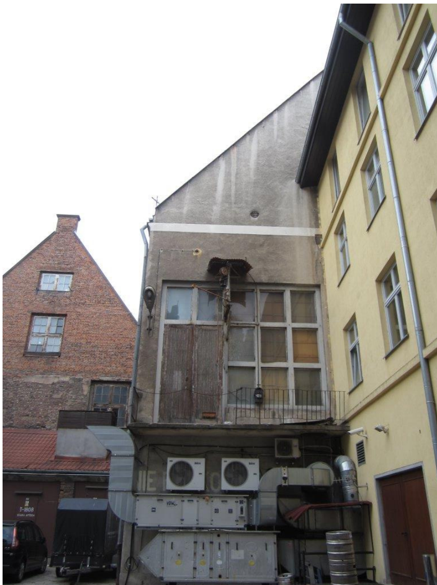
Fot. 39 Ściana budynku Malarni od strony podwórza. Widoczne stare okna i drzwi o niskich parametrach cieplnych. Okna są zaślepione od wewnątrz ponieważ w przestrzeni sceny Malarnia są niepotrzebne. Krawędź stropu niezabezpieczona balustradą. Wciągarka zamontowana na profilu okiennym.
