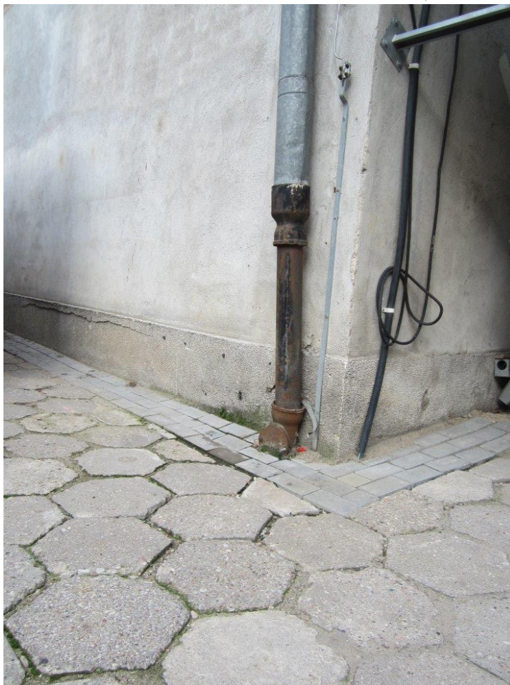
Fot. 36 Pozioma rysa w cokole w miejscu zamurowanego przejścia. Nieszczelne połączenie odcinków rury spustowej. Źle zamocowana rura do ściany.
