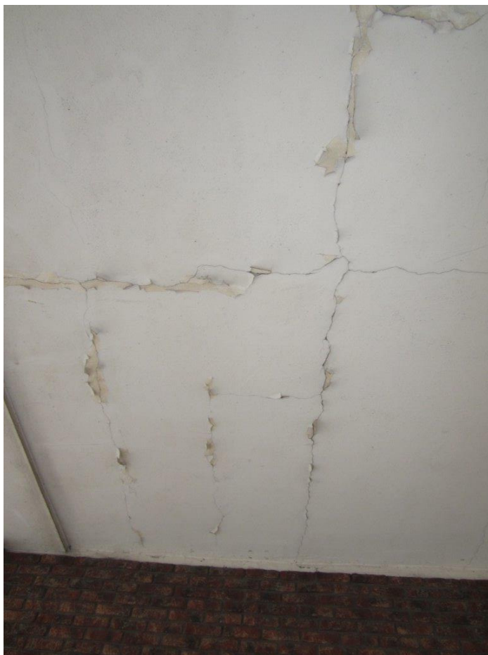
Fot. 41 Zarysowania tynków pod stropem łącznika Malarni. Najprawdopodobniej wykonano ocieplenie niezgodnie z technologią. Złe mocowanie płyt izolacyjnych, brak siatki pod tynkiem.
