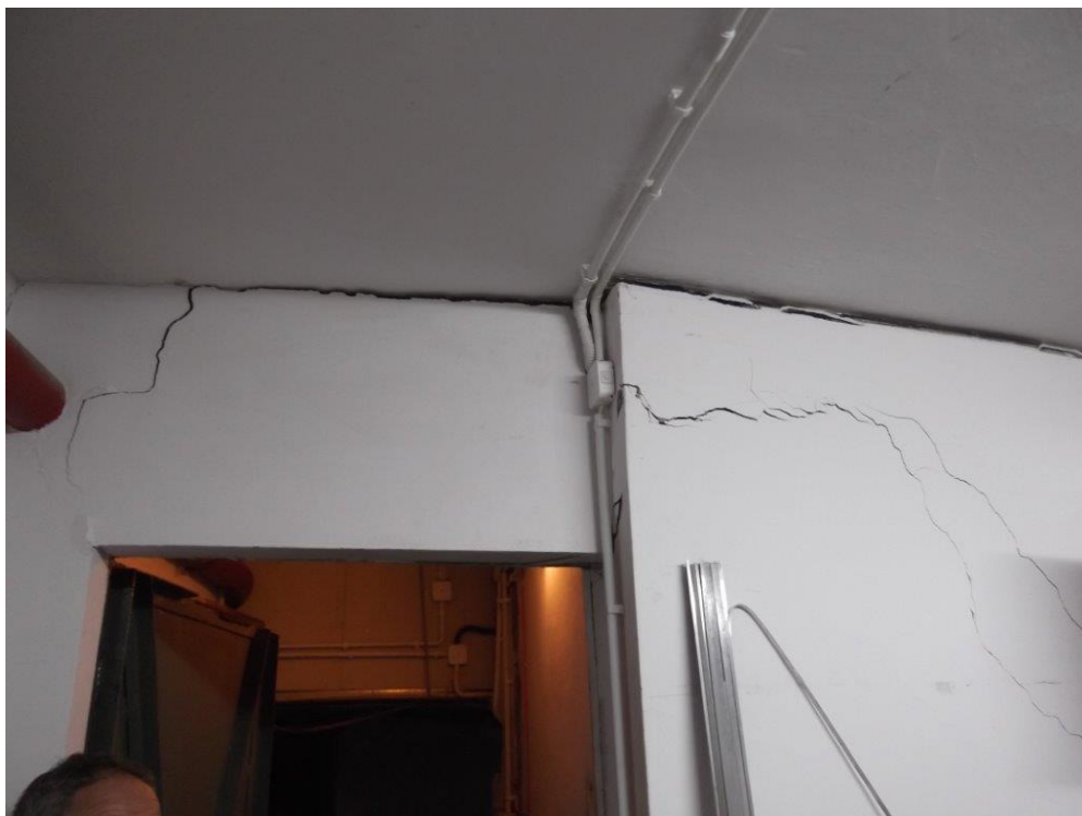
Fot. 6 Pęknięte i odspojone od stropu ścianki działowe na skutek osiadania posadzki – piwnica. Szczelina ma rozwartość około 1,0 cm.
