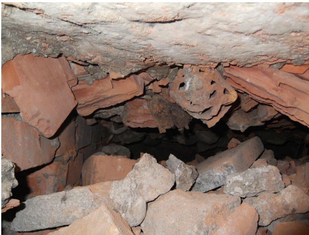
Fot. 27 Odkrywką posadzki. Widoczna pustka pod posadzką oraz materiał użyty na zasypkę – gruz ceglany. Część materiału jest przyklejona do spodu płyty posadzkowej. Osiadanie w tym miejscu osiągnęło wartość ok. 20 cm
