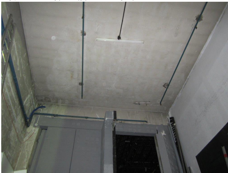
Fot. 41 Zarysowania tynków pod stropem łącznika Malarni. Najprawdopodobniej wykonano ocieplenie niezgodnie z technologią. Złe mocowanie płyt izolacyjnych, brak siatki pod tynkiem.
