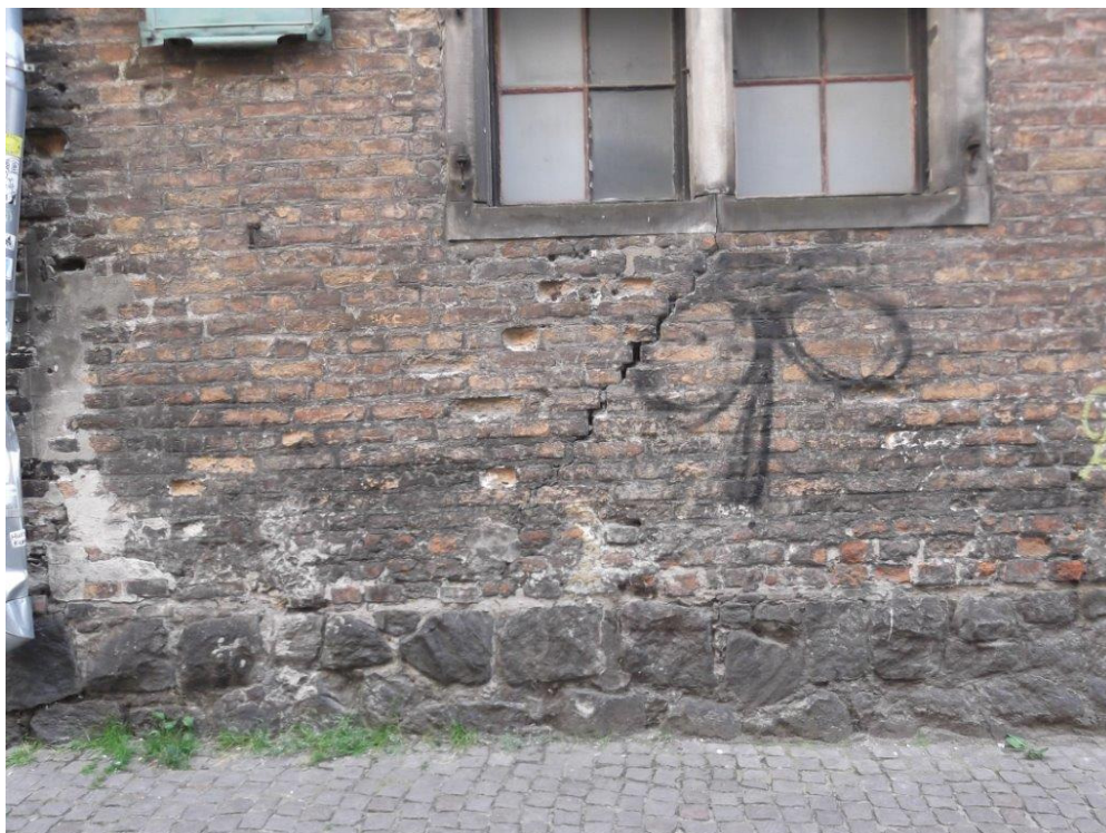
Fot. 67 Skorodowany mur od strony ulicy Teatralnej. Pęknięcie w podokienniku.
