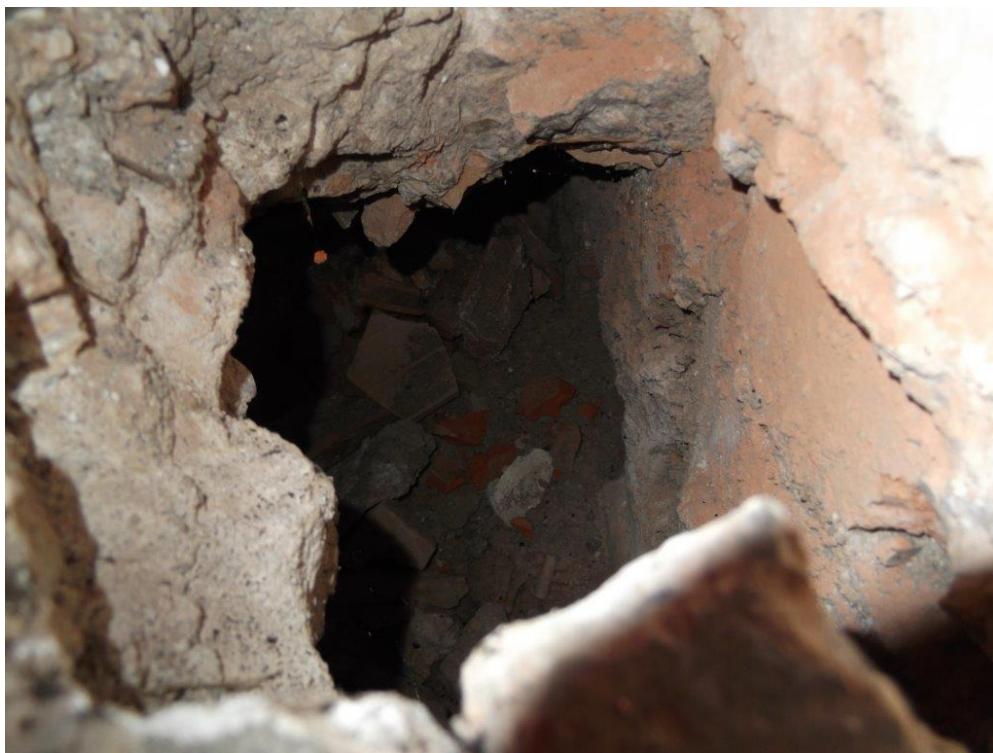
Fot. 25 Odkrywka posadzki. Widoczna pustka pod posadzką oraz materiał użyty na zasypkę – gruz ceglany
