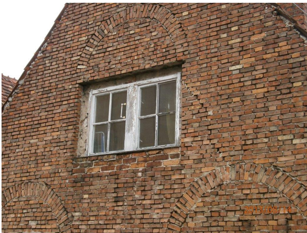
Fot. 55 Ściana Starej Apteki od strony ul. Teatralnej. Widoczna zdekapitalizowana stolarka okienna i rysy. Szczyt odbudowany po wojnie bez rekonstrukcji detalu.
