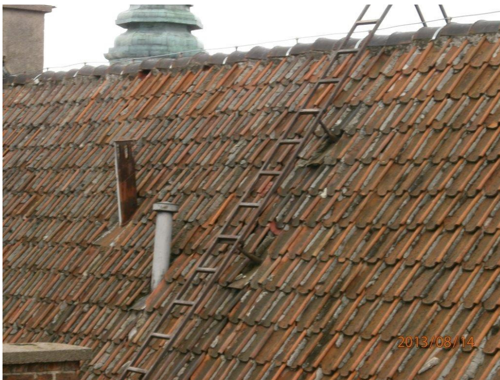
Fot. 61 Znacznie skorodowane dachówki. Dachówka jest całkowicie wyeksploatowana i wymaga wymiany.
