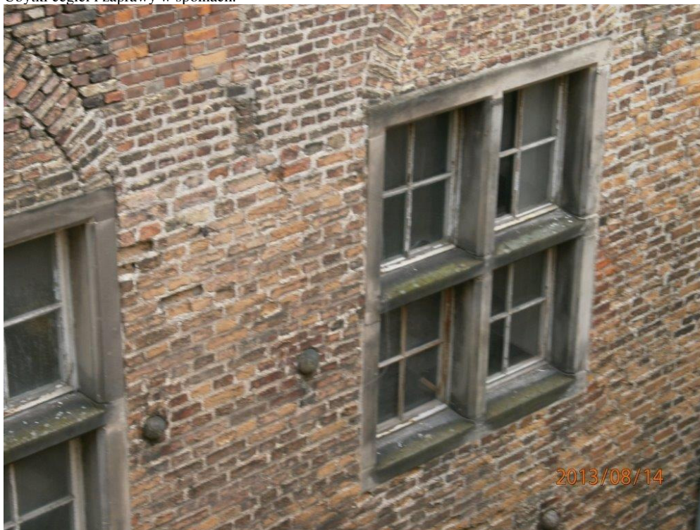
Fot. 53 Ściana Starej Apteki od strony ul. Teatralnej. Widoczna zdekapitalizowana stolarka okienna.
