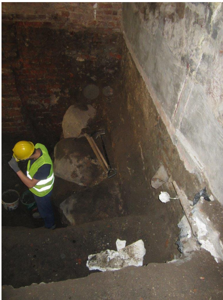
Fot. 68 odkrywka archeologiczna na połączeniu muru Przejścia Bramnego od strony ulicy ze ścianą boczną Starej Apteki. Widoczne głazy wykorzystane do fundamentowania ściany Starej Apteki
