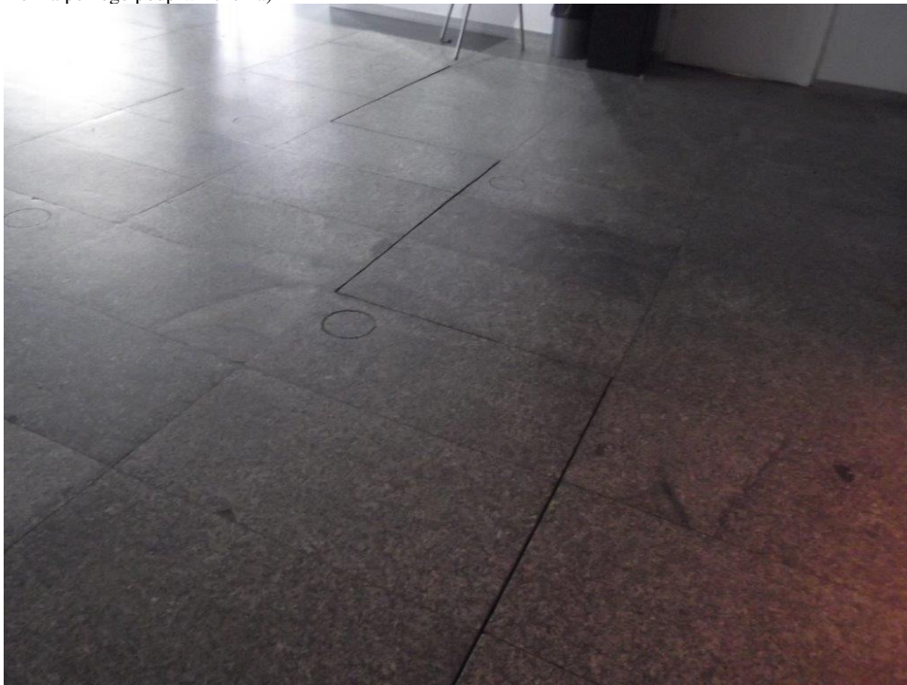
Fot. 2 Uskoki i szczeliny na stykach płyt spowodowane osiadaniem podłoża pod posadzkami – hol wejściowy parter (na tym obszarze nie ma pełnego podpiwniczenia). Widoczne ślady po wzmocnieniach mikropalami.
