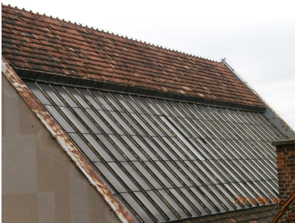
Fot. 47 Dach malarni. Widoczne szklenie, skorodowane dachówki oraz opierzenia.
