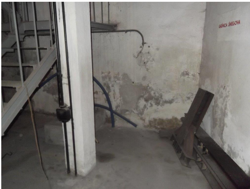
Fot. 7 Zawilgocona ściana wewnętrzna piwnic. Najniższy poziom pod sceną w pomieszczeniu mechanizmu obracania sceny.
