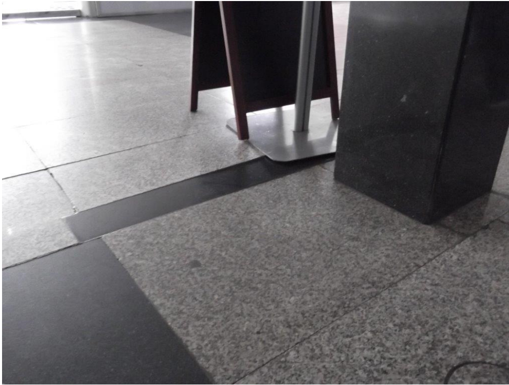
Fot. 1 Uskoki na stykach płyt spowodowane osiadaniem podłoża pod posadzkami – hol wejściowy parter (na tym obszarze nie ma pełnego podpiwniczenia)
