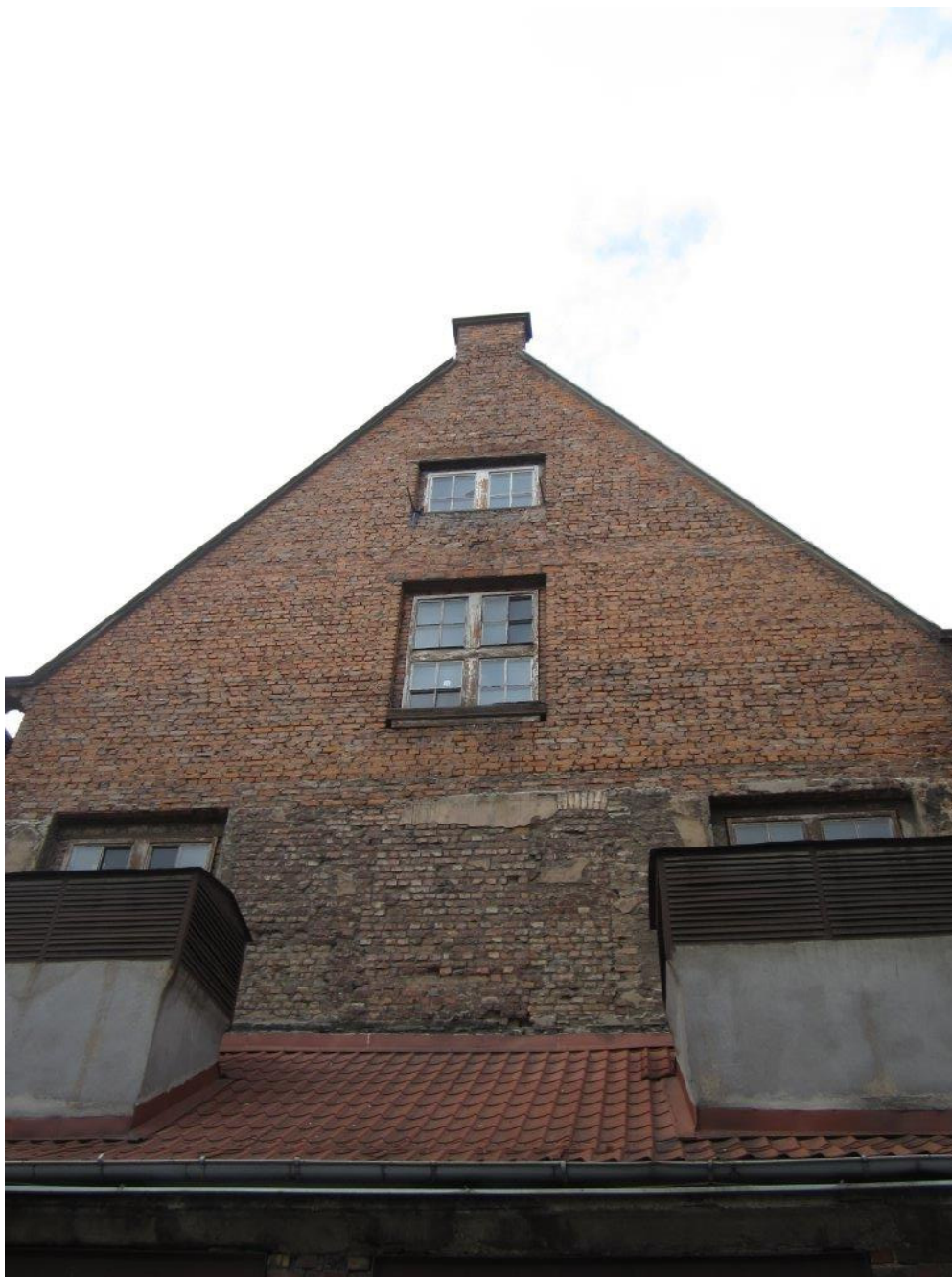
Fot. 63 Ściana szczytowa od strony podwórza. Zniszczona stolarka. Ściana odbudowana po zniszczeniach wojennych bez zachowania detalu.
