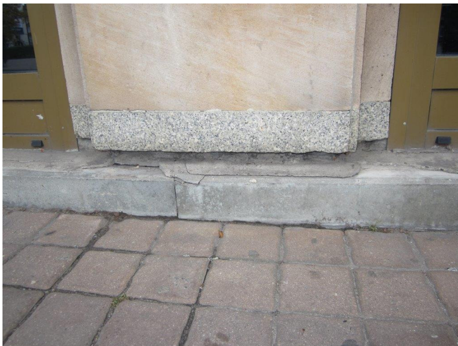
Fot. 29 Strefa cokołowa filara przy podcieniu. Widoczne osiadanie nawierzchni chodnika. Szczelina przy ścianie jest miejscem, przez które woda penetruje w grunt spływając po ścianie piwnic powodując jej zawilgocenie.
