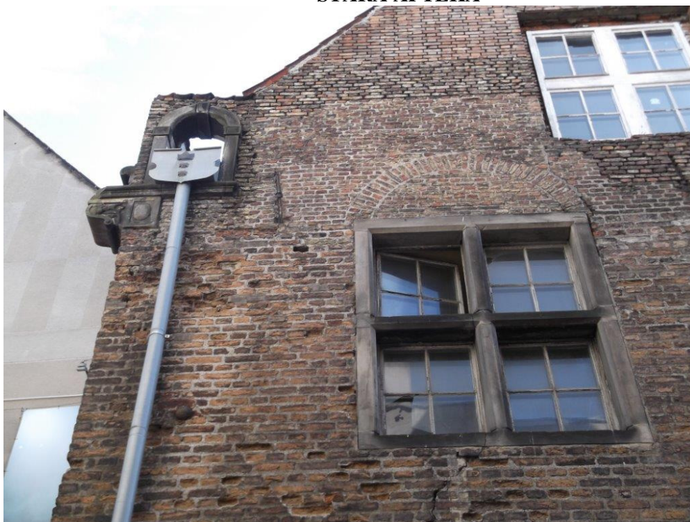
Fot. 52 Ściana Starej Apteki od strony ul. Teatralnej. Widoczna zdekapitalizowana stolarka oraz rysa w podokienniku. Ubytki cegieł i zaprawy w spoinach.
