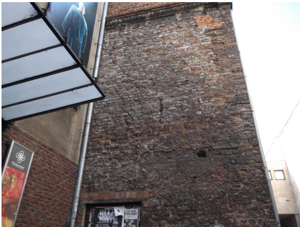
Fot. 67 Skorodowany mur od strony ulicy Teatralnej (ściana przylegająca do malarni). Widoczne ukośne pęknięcie.
