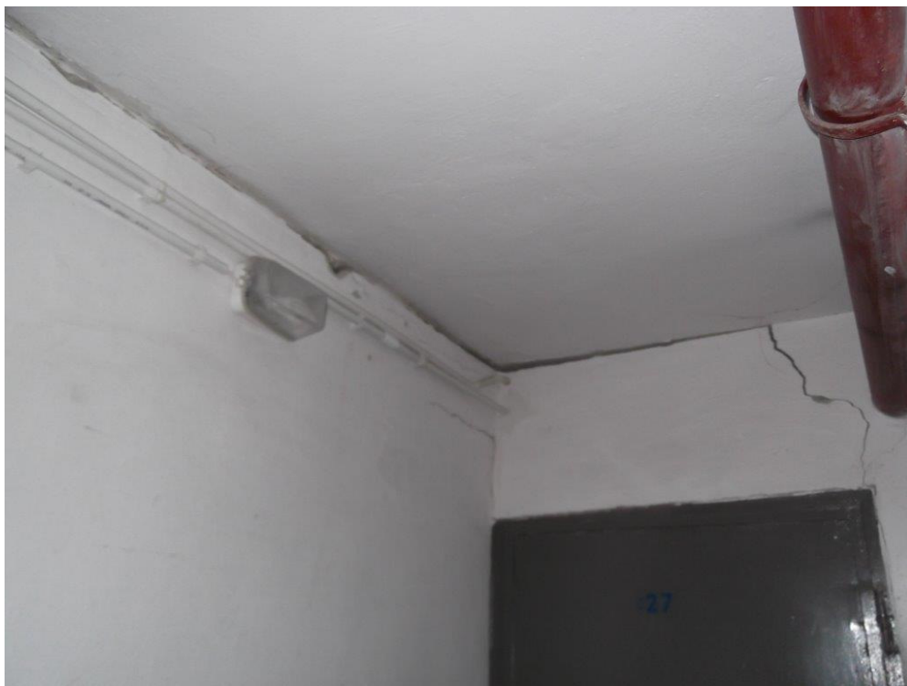
Fot. 19 Rysy na ścianie działowej. Widać nieskuteczność napraw powierzchniowych, co wskazuje na ciągłą aktywność rys.
