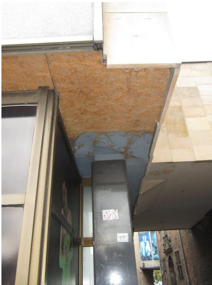
Fot. 35 Zerwana obudowa w podcieniu. Tymczasowe naprawy płytą OSB
