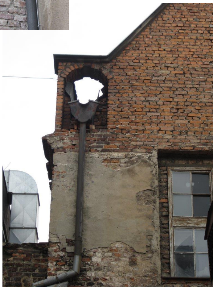
Fot. 64. Kosze zlewowe od strony podwórza. Niewłaściwe wiązanie muru. Brak tynku na większości powierzchni ściany.
