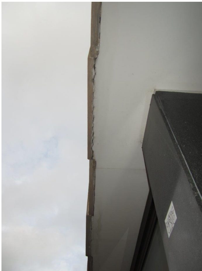
Fot. 31 Odspojona okładzina elewacyjna – w czasie remontu konieczny jest przegląd mocowania okładzin
