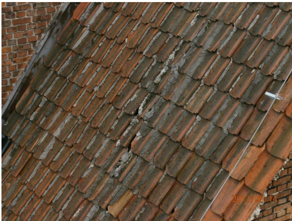
Fot. 62 Znacznie skorodowane i spękań dachówki. Dachówka jest całkowicie wyeksploatowana i wymaga wymiany.
