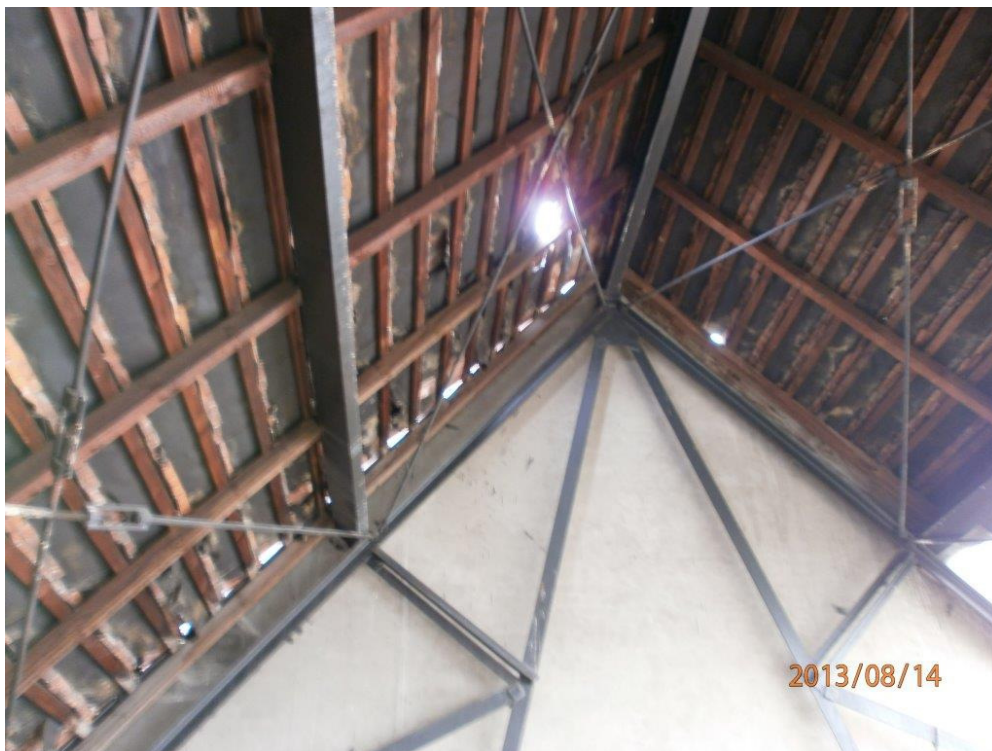
Fot. 45 Nieszczelny dach malarni, brak dachówek. Część napraw wykonana w 2013 roku jest nieskuteczna. Obecnie też w tych miejscach nadal występują nieszczelności
