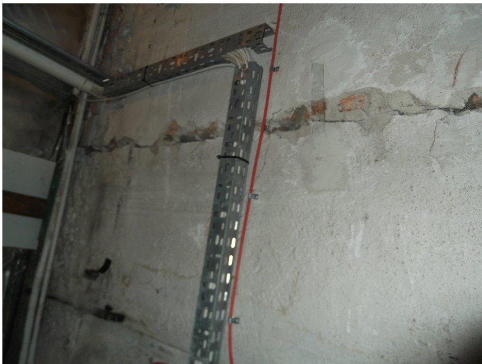
Fot. 8 Pęknięcie w ścianie na styku wentylatorowi z budynkiem głównym. Nie wykonstruowano tu dylatacji. W czasie prac remontowych zaleca się odsłonięcie szczeliny i zastosowania profilu maskującego. Nie ma to wpływa na nośność konstrukcji, ale może być potencjalnym miejscem przecieków.
