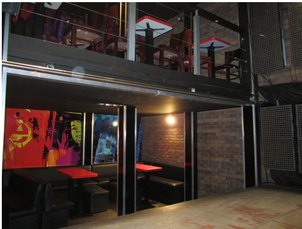
Fot. 51 Pomieszczenia Klubu Parlament. Antresola o niezależnej, lekkiej konstrukcji wbudowana w kubaturę pomieszczenia. Konstrukcja antresoli nie bierze udziału w przenoszeniu obciążeń od elementów konstrukcji budynku
