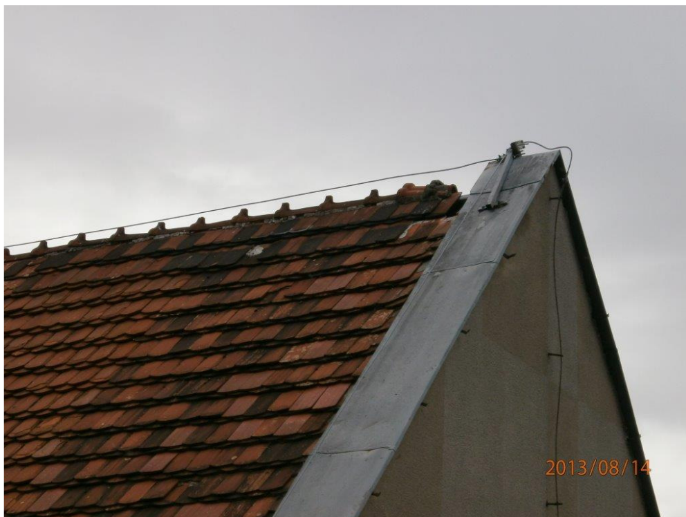
Fot. 49 Dach malarni. Widoczny brak gąsiora. W tym miejscu nadal jest nieszczelny dach pomimo przeprowadzenia napraw.
