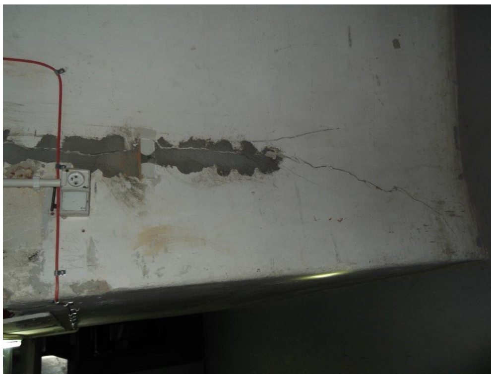
działowej. Widać nieskuteczność napraw powierzchniowych, co wskazuje na ciągłą aktywność rys.
