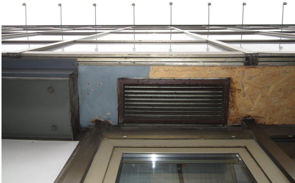
Fot. 34 Zerwana obudowa w podcieniu.
