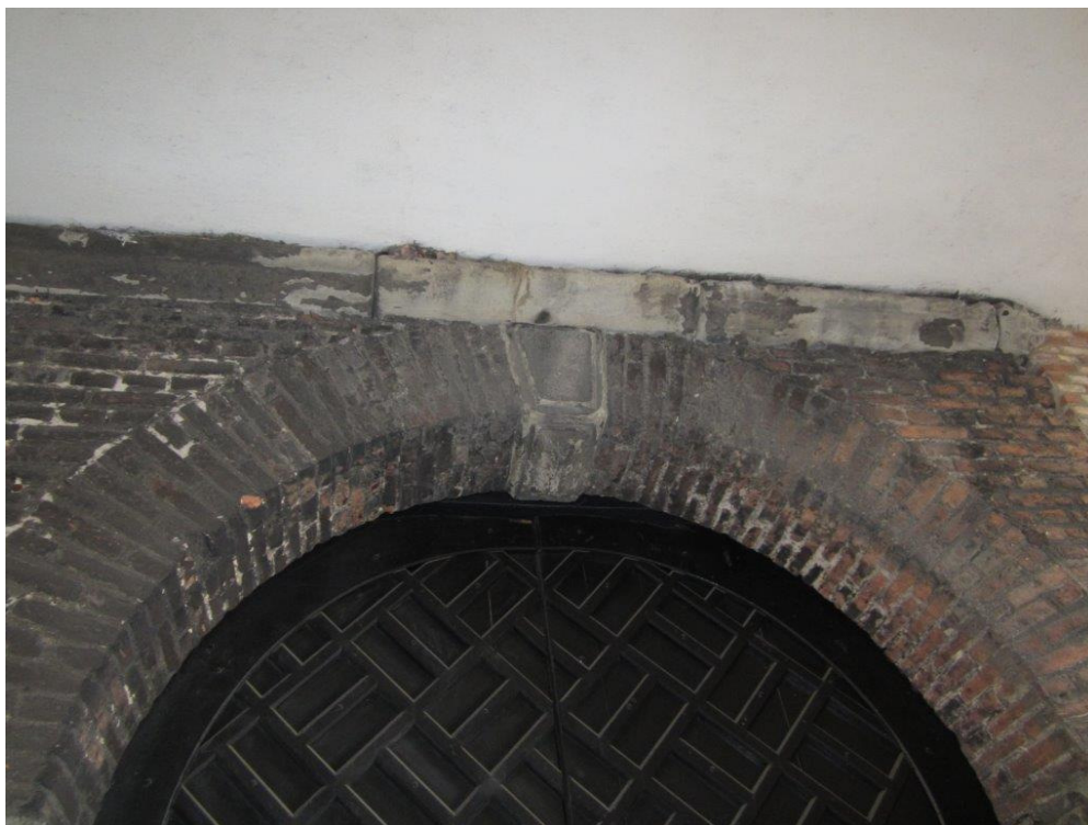
Fot. 65 Przejście bramne. Sklepienie nad bramą. Widoczne fragmenty nieoryginalnych cegieł.
