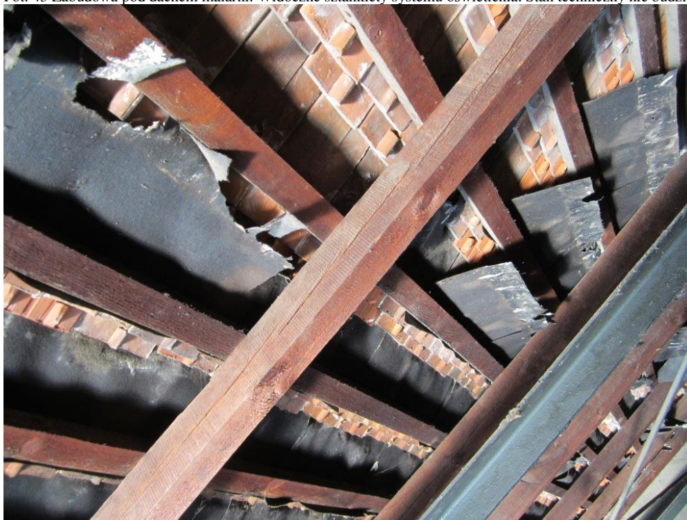
Fot. 44 Prowizoryczne doszczelnienia dachu malarni
