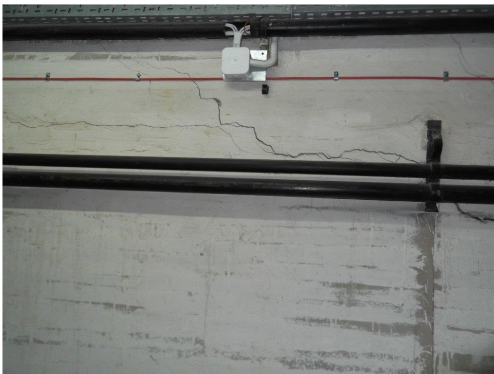
Fot. 22 Rysy na ścianie działowej.
