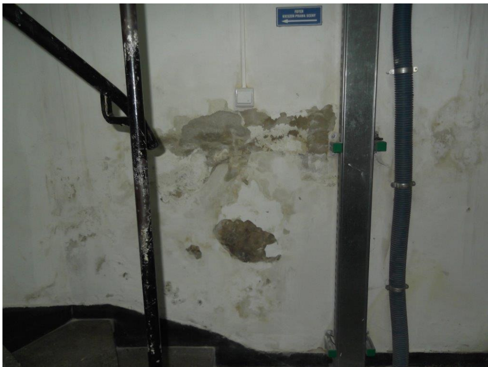
Fot. 24 Zawilgocenie ściany zewnętrznej przy schodach prowadzących do wentylatorowni.
