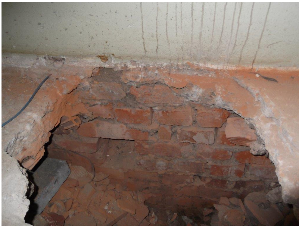
Fot. 26 Odkrywka posadzki. Widoczna pustka pod posadzką oraz materiał użyty na zasypkę – gruz ceglany. Posadzka nie jest zbrojona
