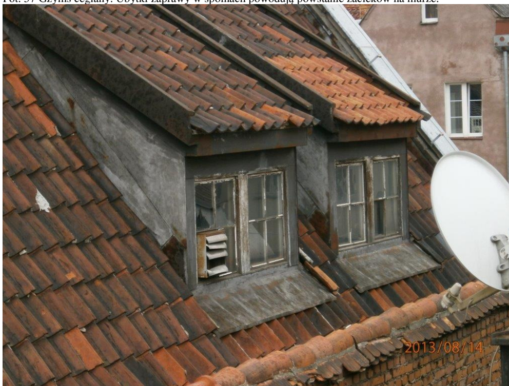
Fot. 58 Nieszczelne obróbki, korozja obudowy lukarn. Zniszczona stolarka okienna.
