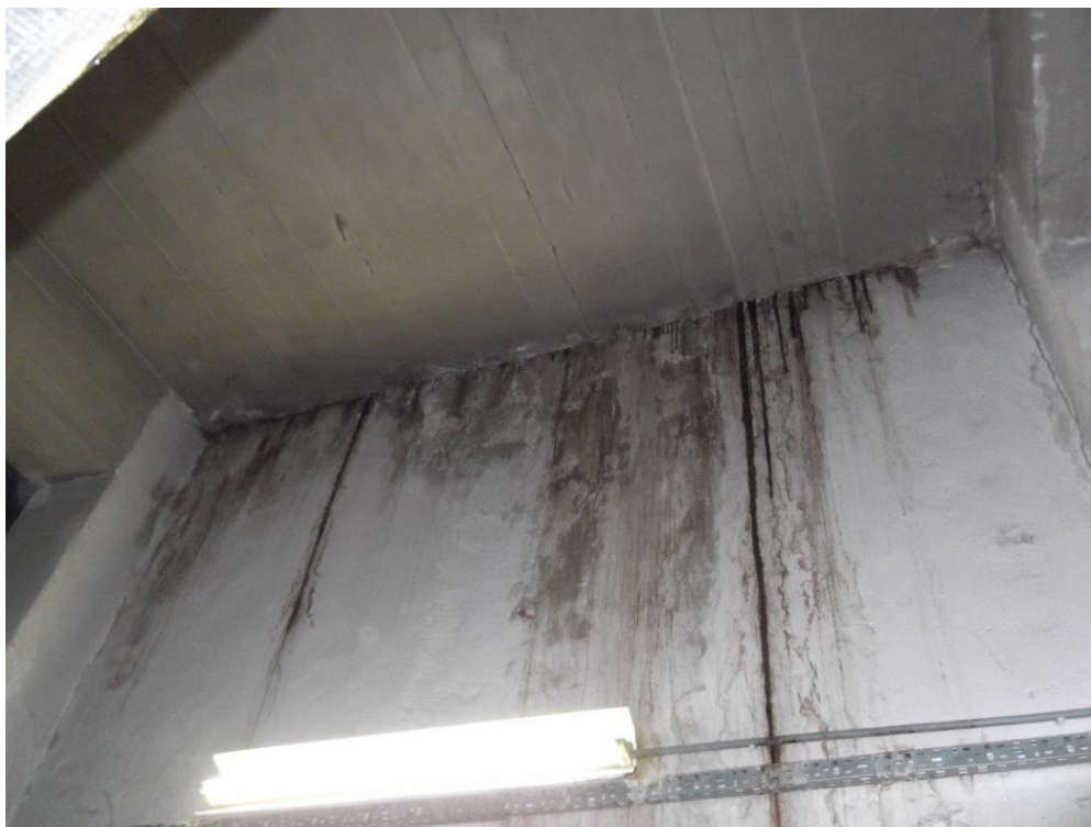
Fot. 11 Zacieki na ścianie w piwnicy. Nieszczelność lub brak izolacji na styku ściana-strop. W tym miejscu przedostają się wody opadowe spływające po zewnętrznej płaszczyźnie ściany piwnic.
