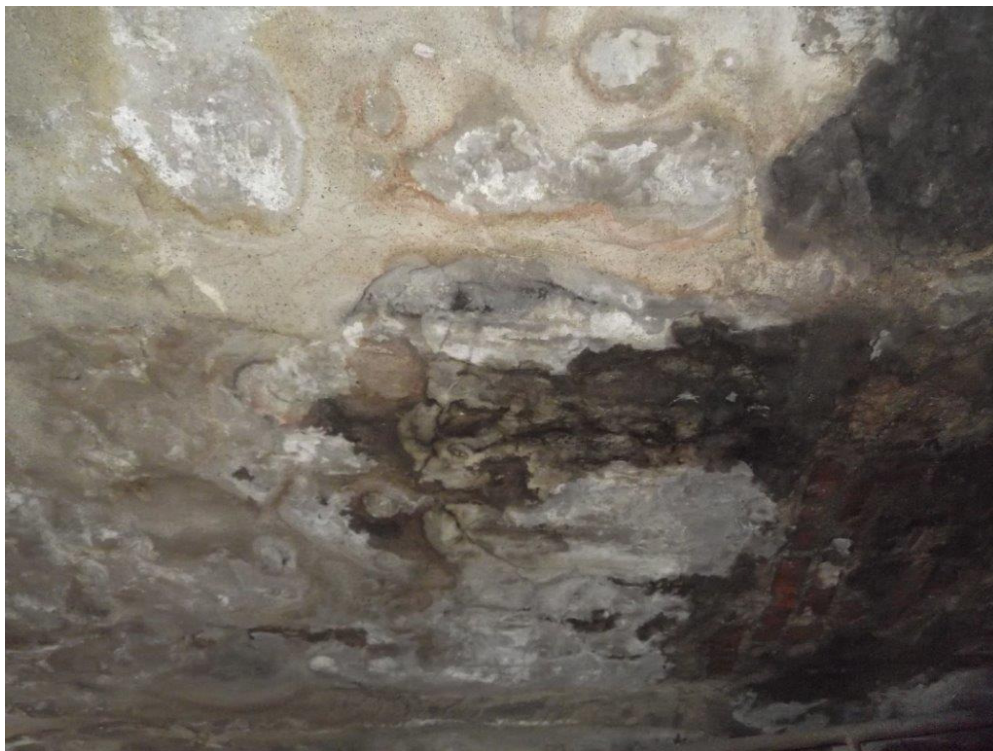
Fot. 12 Wykwity na ścianie zewnętrznej (komora powietrzna przy wentylatorowni). Widoczne są stałe, drobne przecieki wody przez ścianę.
