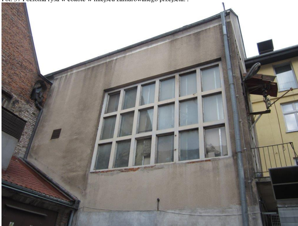
Fot. 38 Ściana budynku Malarni od strony Starej Apteki. Widoczne stare okna o niskich parametrach cieplnych. Okna są zaślepione od wewnątrz ponieważ w przestrzeni sceny Malarnia są niepotrzebne.
