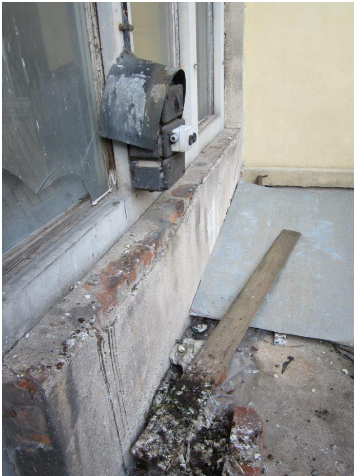
Fot. 40 Ściana budynku Malarni od strony podwórza. Widoczne stare okna i drzwi o niskich parametrach cieplnych. Brak obróbki parapetu. Okna są zaślepione od wewnątrz ponieważ w przestrzeni sceny Malarnia są niepotrzebne. Krawędź stropu
