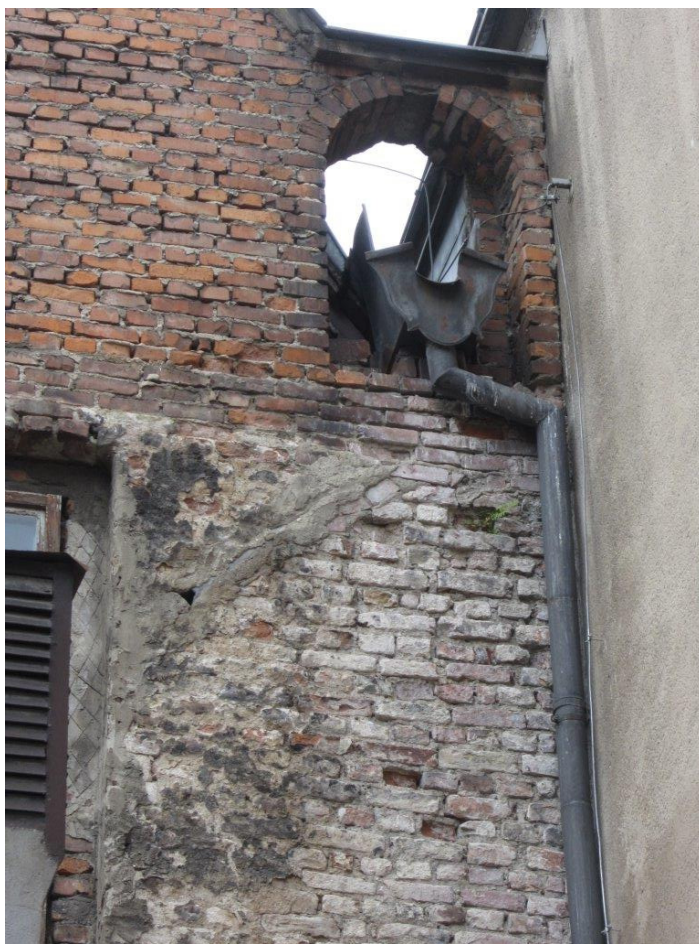
Fot. 64. Kosze zlewowe od strony podwórza. Niewłaściwe wiązanie muru. Brak tynku na większości powierzchni ściany.
