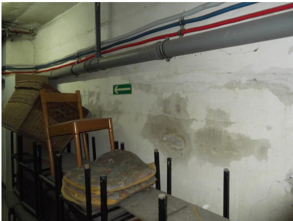
Fot. 21 Rysy na ścianie działowej. Widać zawilgocenie ściany..
