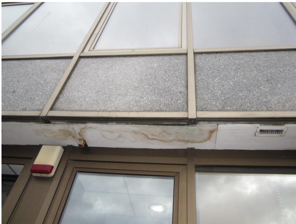
Fot. 33 Zacieki na nadprożu. Woda najprawdopodobniej przenika przez styki fasady.
