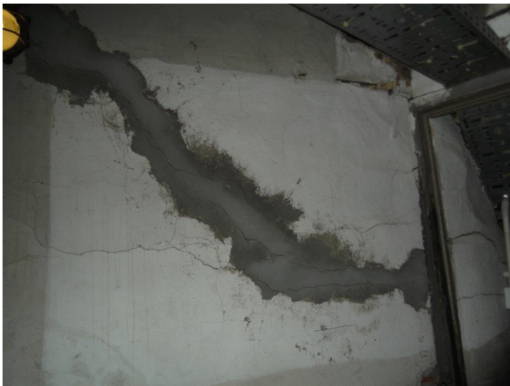
Fot. 15 Rysy na ścianie działowej. Widać nieskuteczność napraw powierzchniowych, co wskazuje na ciągłą aktywność rys.
