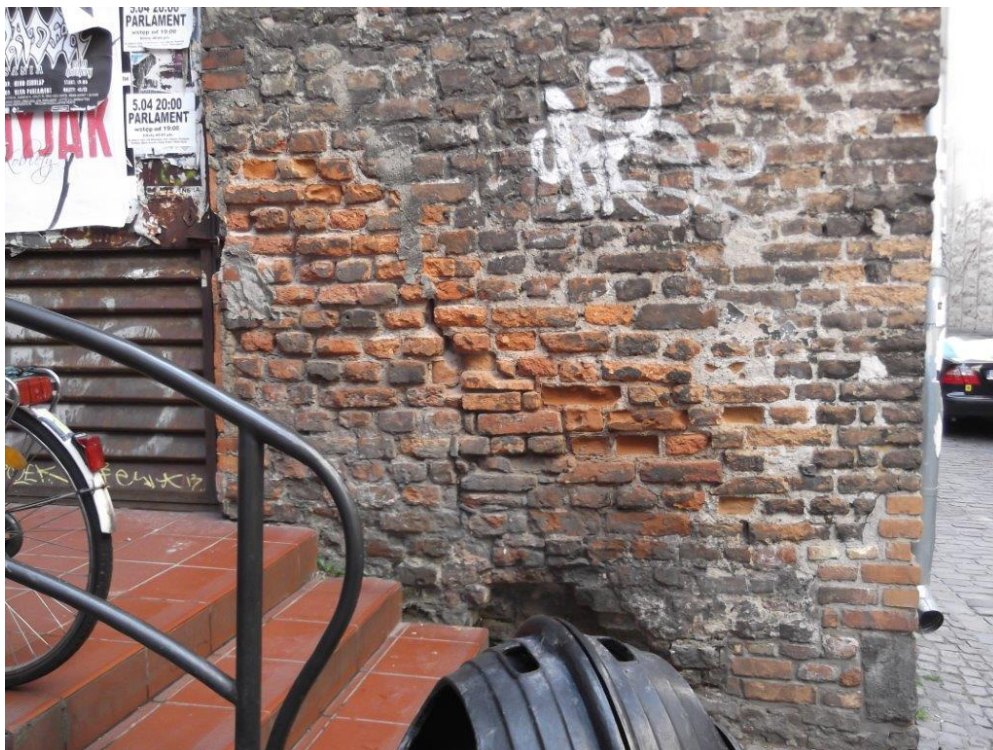
Fot. 66 Skorodowany mur od strony ulicy Teatralnej (ściana przylegająca do malarni)
