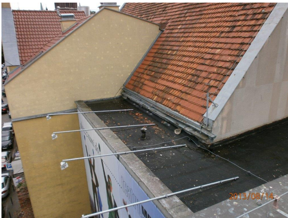
Fot. 50 Dach malarni i łącznika. Skorodowane dachówki zsuwają się na płaską część dachu i do rynny. Brak zabezpieczeń przed zsuwaniem śniegu.
