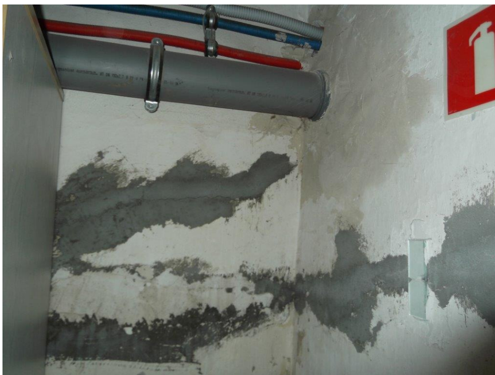
Fot. 20 Rysy na ścianie działowej. Widać nieskuteczność napraw powierzchniowych, co wskazuje na ciągłą aktywność rys.
