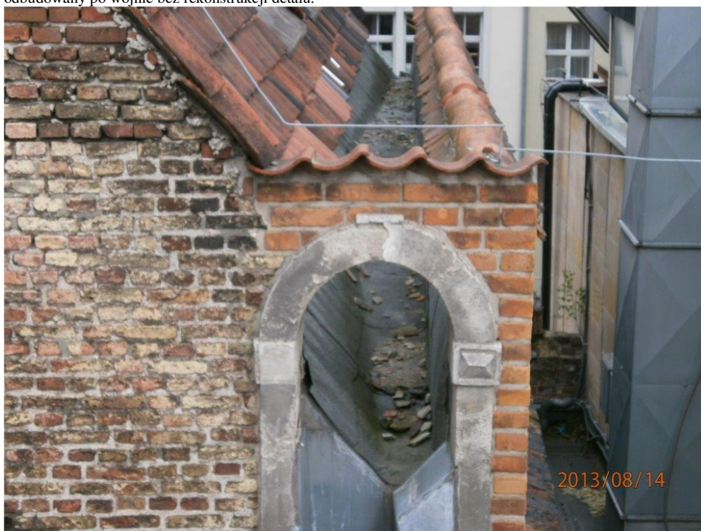
Fot. 56 Koryto zlewowe od strony przejścia bramnego. Widoczne pokruszone dachówki spadające z dachu.
