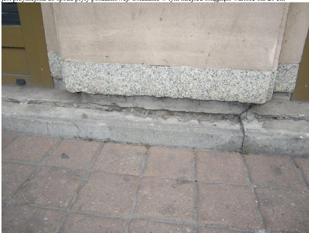
Fot. 28 Strefa cokołowa filara przy podcieniu. Widoczne osiadanie nawierzchni chodnika. Szczelina przy ścianie jest miejscem, przez które woda penetruje w grunt spływając po ścianie piwnic powodując jej zawilgocenie.
