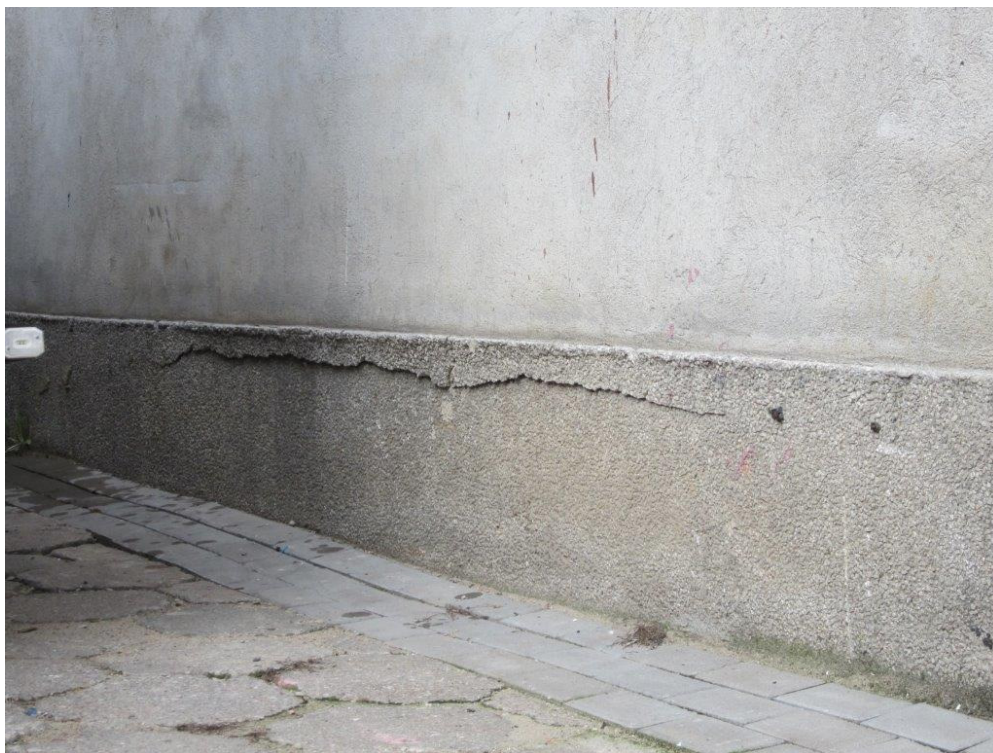
Fot. 37 Pozioma rysa w cokole w miejscu zamurowanego przejścia. .
