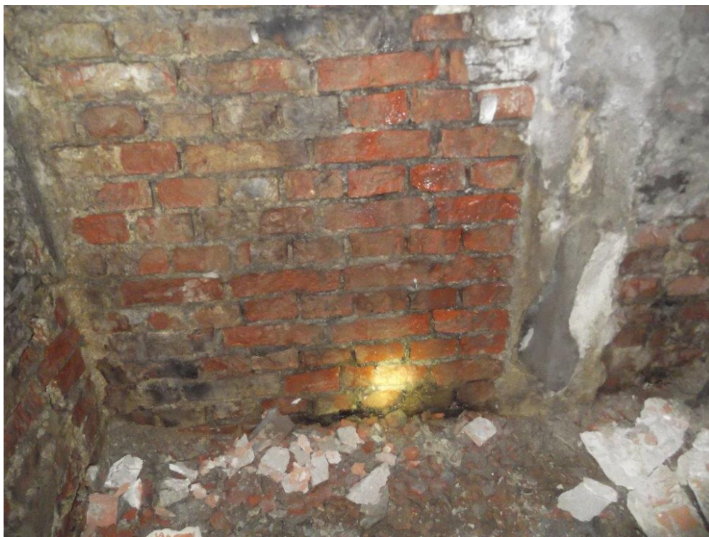
Fot. 13 Pozbawiona tynku ściana w komorze powietrznej przy wentylatorowi. Ściana jest stale zawilgacana.
