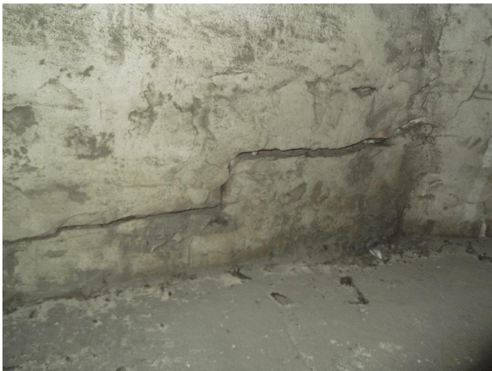
Fot. 14 Pęknięcie w ścianie wydzielającej komorę powietrzną na skutek osiadania podłoża. Ściana jest ustawiona na posadzce jak ściana działowa.
