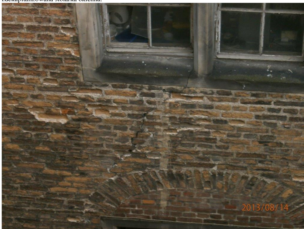
Fot. 55 Ściana Starej Apteki od strony ul. Teatralnej. Widoczna zdekapitalizowana stolarka okienna i rysa w podokienniku.
