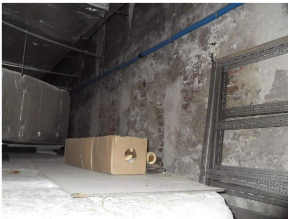
Fot. 10 Pozbawiona tynku ściana wentylatorowni w piwnicy na skutek dużej wilgotności. Widoczne odsłonięte rdzenie żelbetowe przejmujące parcie gruntu. Konieczne jest zaizolowanie i osuszenie ściany i zapewnienie prawidłowej wentylacji pomieszczenia.
