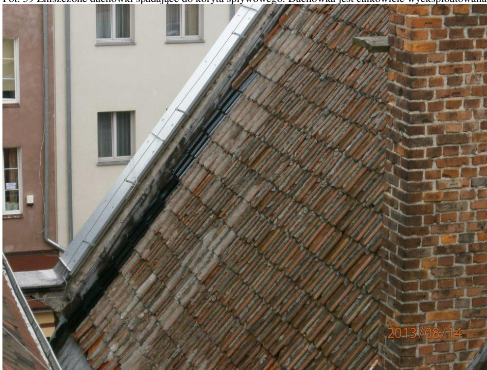
Fot. 60 Znacznie skorodowane dachówki. Dachówka jest całkowicie wyeksploatowana i wymaga wymiany.
