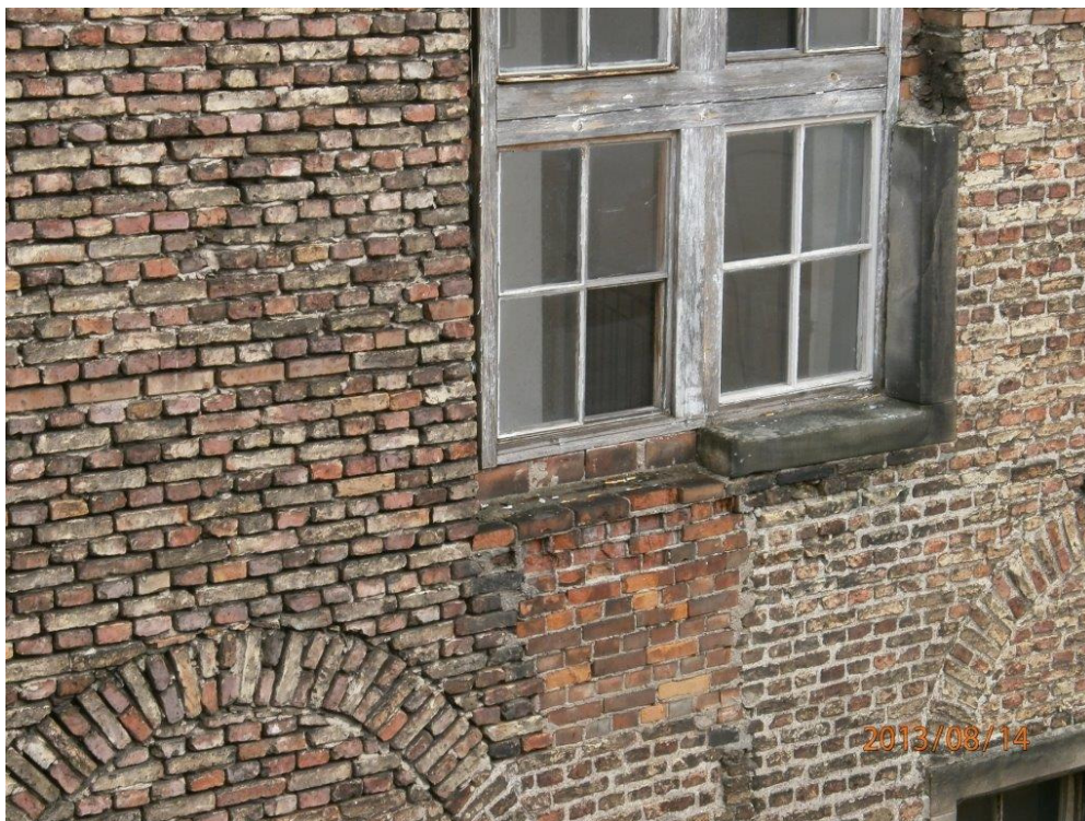
Fot. 54 Ściana Starej Apteki od strony ul. Teatralnej. Brak fragmentu parapetu kamiennego i obramowania okna. Widoczna zdekapitalizowana stolarka okienna.
