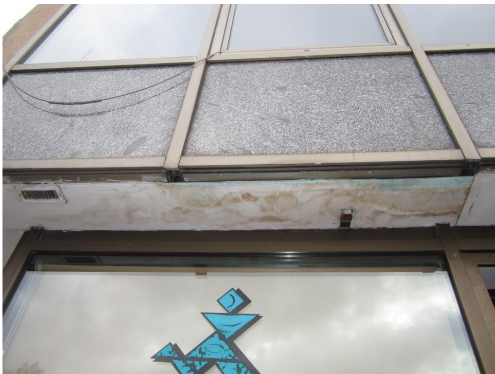
Fot. 32 Zacieki na nadprożu. Woda najprawdopodobniej przenika przez styki fasady.
