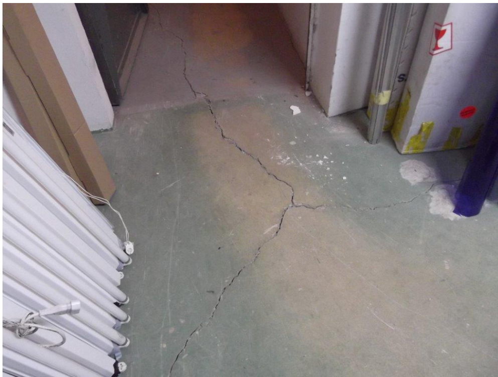
Fot. 4 Pęknięcie posadzki piwnic na skutek osiadania podłoża pod posadzką. W tym miejscu występuje koncentracja obciążeń od ścianek
